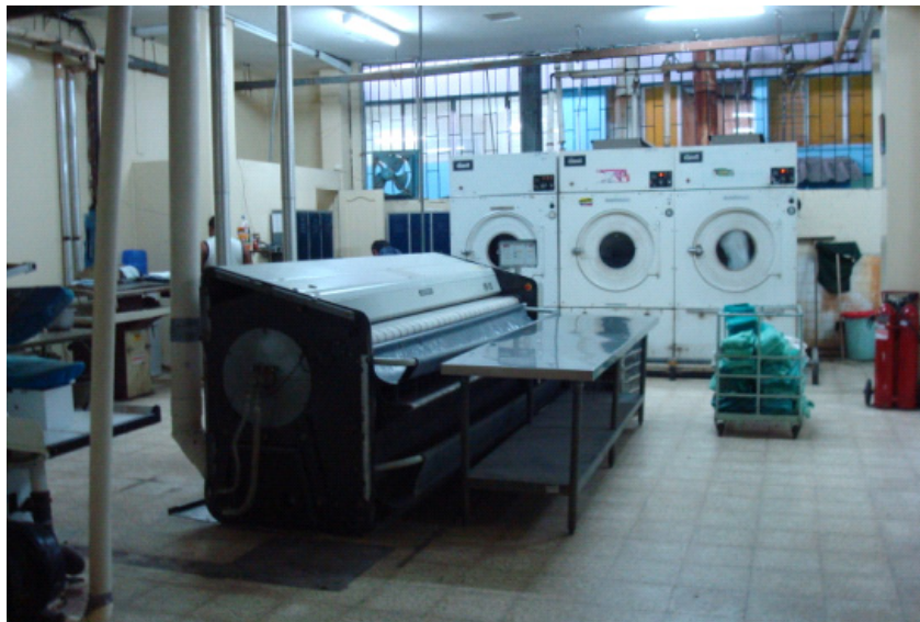
Fig. 1.4 Área de Lavandería
