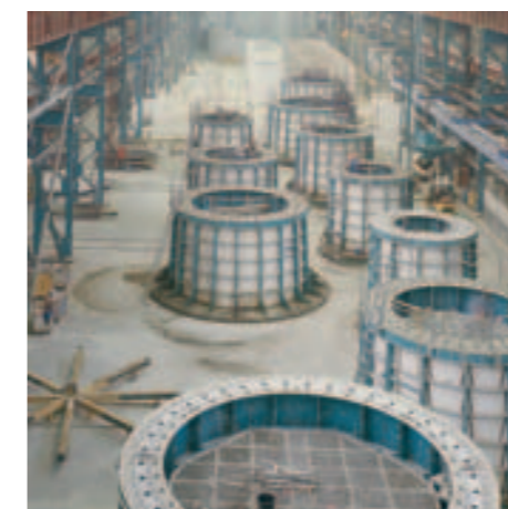
Producción de torres de hormigón prefabricadas ENERCON
