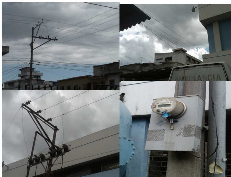
Fig.1.23 Proceso de energización del Hospital.
