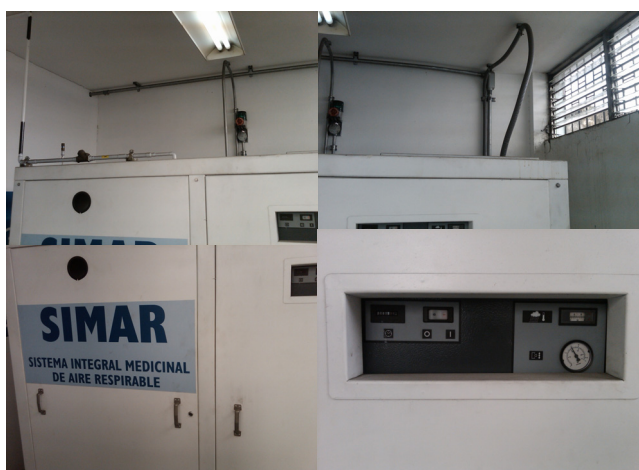
Fig.1.19 Equipo de la central de aire medicinal.
