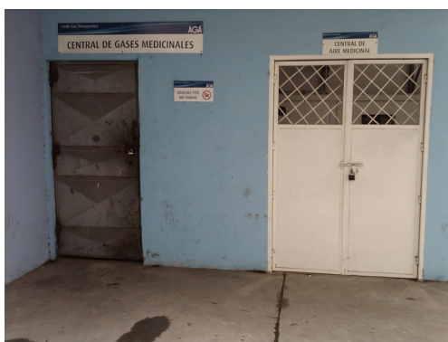
Fig.1.17 Exteriores de la central de gases medicinales y la central de aire medicinal.
