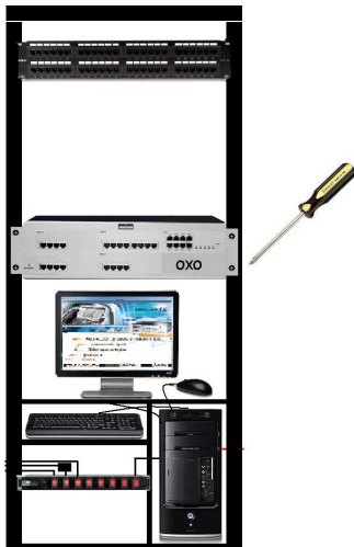
Figura 1. Omnipcx instalado en el rack
