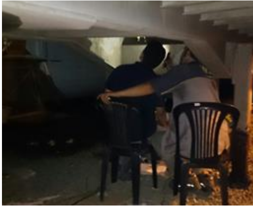
Figura 1. Instalación de sistema eléctrico.
