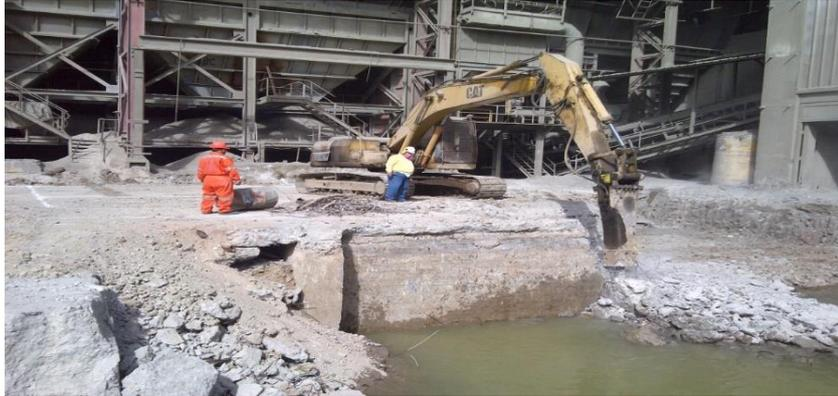
**FIGURA 3.4.- DEMOLICIÓN DE CIMENTACIÓN EXISTENTES**
