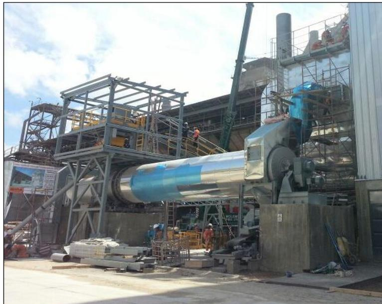
**FIGURA. 3.17. SECADOR DE PUZOLANA – CONEXIÓN FILTRO SECADOR**
