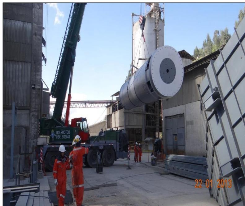
**FIGURA. 3.13 IZAJE DEL SECADOR PUZOLANA 35 TPH**
