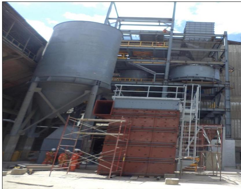
**FIGURA 3.9. ARMADO DE FILTRO DESEMPOLVADO DEL SECADOR**
