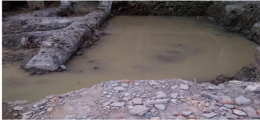
**FIGURA 3.5. EXCAVACIÓN COMPLETA DEL TERRENO, HASTA COTA DE DESPLANTE.**
