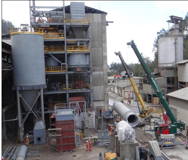
**FIGURA. 3.16. MONTAJE DE SECADOR DE PUZOLANA**
