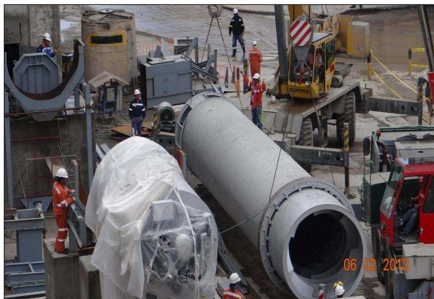
**FIGURA. 3.15 MONTAJE DE TAMBOR DEL SECADOR DE PUZOLANA**
