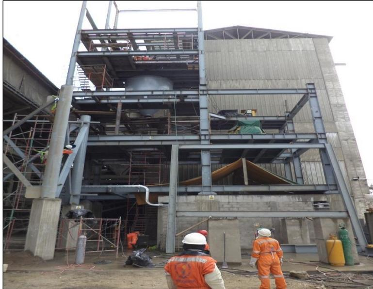
**FIGURA 3.8. MONTAJE DE ESTRUCTURA METÁLICA EDIFICIO TRITURACIÓN.**
