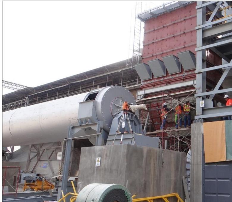
**FIGURA 3.12. ESQUEMA SECADOR-FILTRO PUZOLANA MONTAJE**
