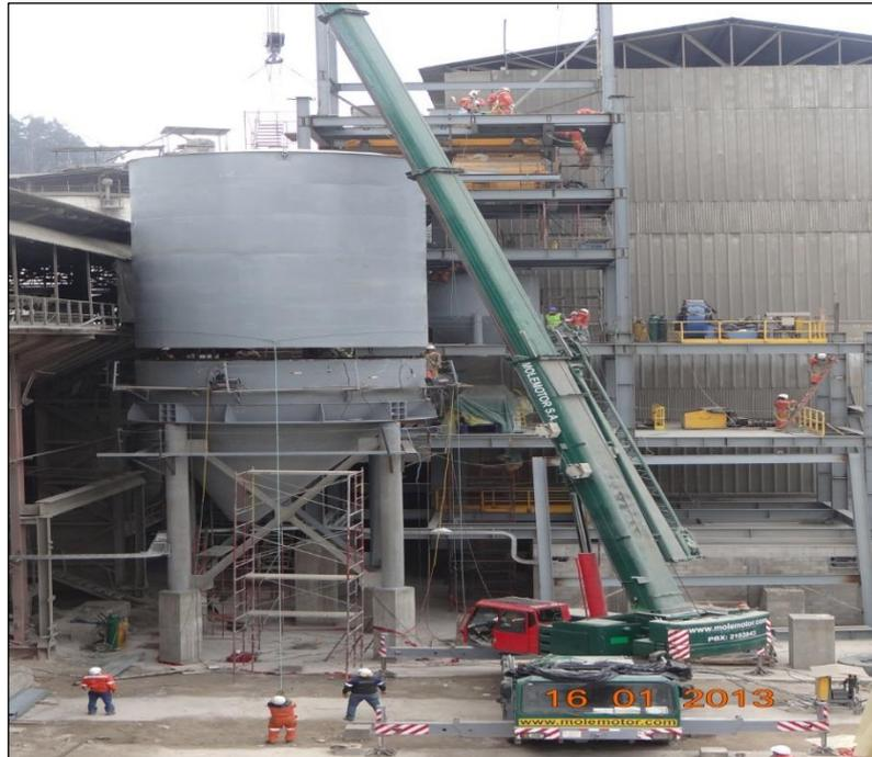
**FIGURA. 3.22. MONTAJE SILO PUZOLANA SECA**
