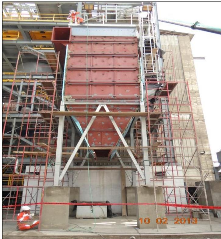
**FIGURA 3.11. FILTRO DESEMPOLVADO SECADOR PUZOLANA SCHEUCH**
