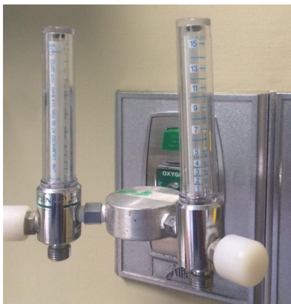
Figura A4.7: Conector doble en toma de Oxígeno
