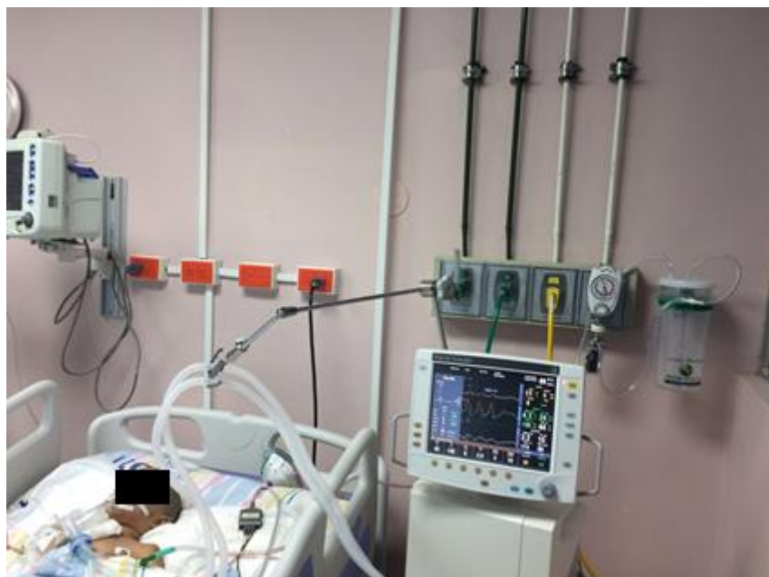
Figura A4.8: Conector simple en toma de Aire Medicinal
