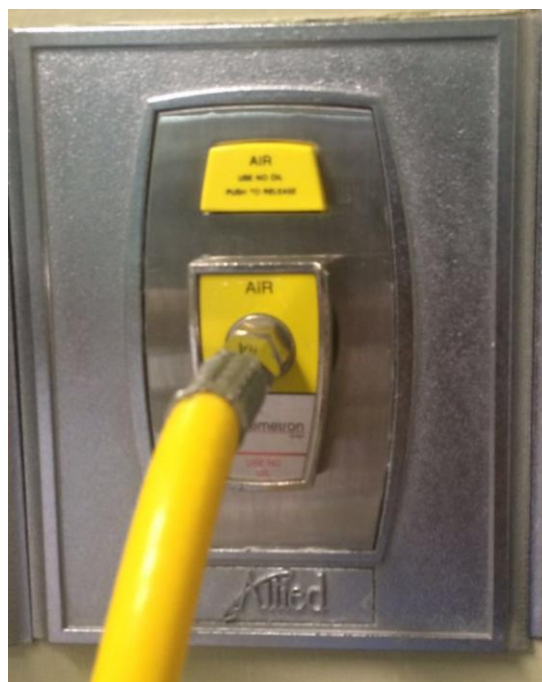
Figura A4.8: Conector simple en toma de Aire Medicinal
