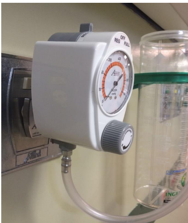
Figura A4.6: Conector de toma de Vacío
