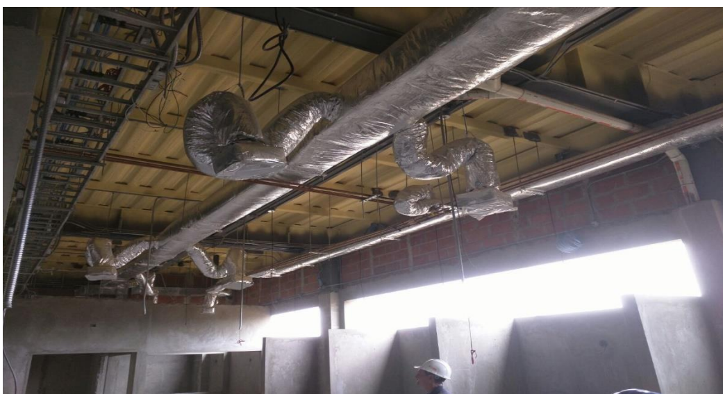
Figura A4.3: Zona de Diálisis – En Construcción
