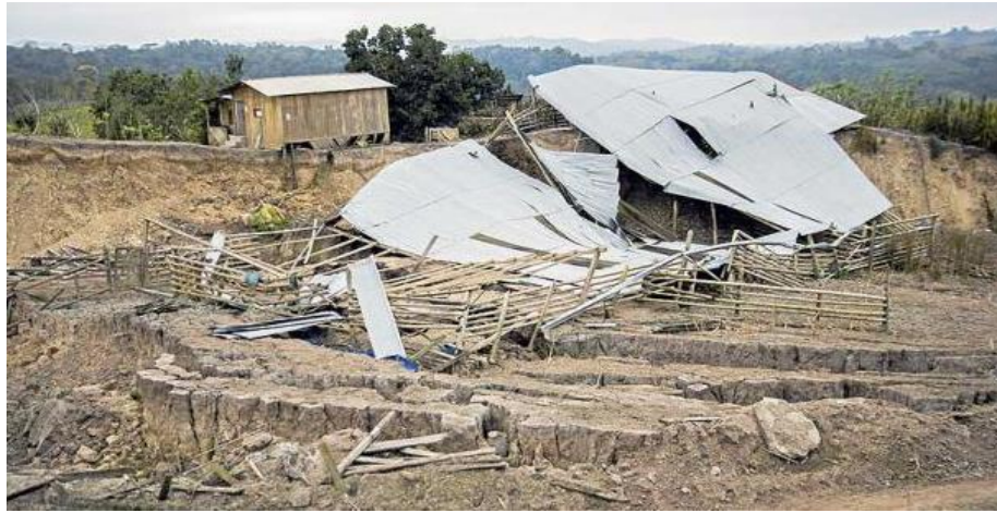
Figura 1.1 Hundimiento del terreno por licuefacción del suelo. Fuente: Diario El Comercio, 2016
