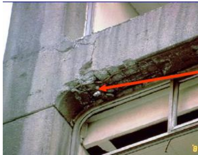
Figura 6.14 Pérdida de recubrimiento y pandeo de refuerzo longitudinal suscitado en una edificación durante el sismo de México 85 por falta de confinamiento en la zona de articulación plástica.
