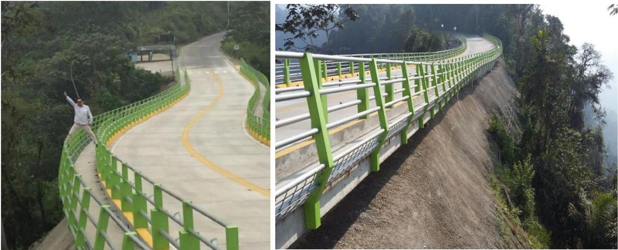
Imagen 11 Paso Pinhuapungo con solución geotécnica aplicada (Chávez, 2016)
