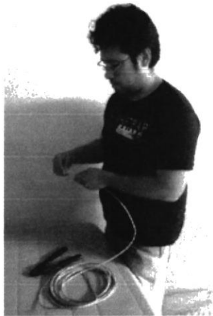
Figura 4-8: Procediendo a ingresar los pares de hilos en el conector RJ45
