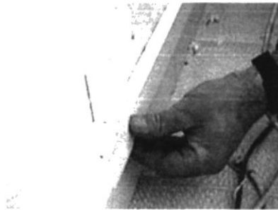
Figura 4-19: Angulo interno para canaletas
