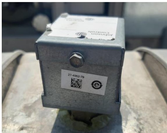
Figura 1.7 Sensor de Temperatura
