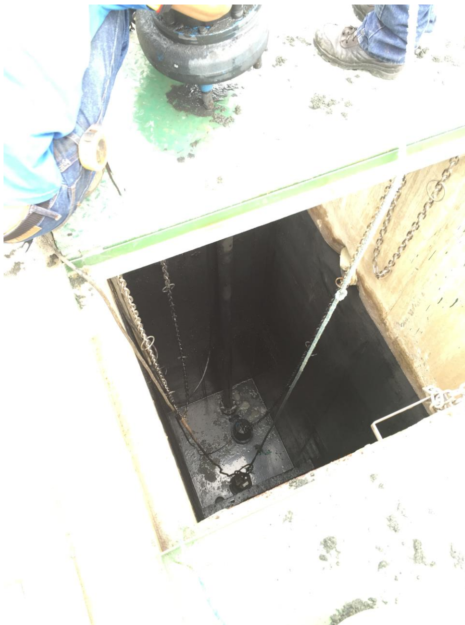
Figura 3.4: Limpieza completa de cisterna de aguas residuales.
