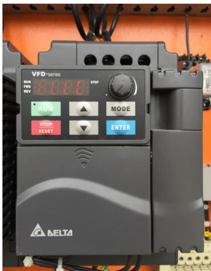
Figura 1.4: Variador de frecuencia de 5HP.
