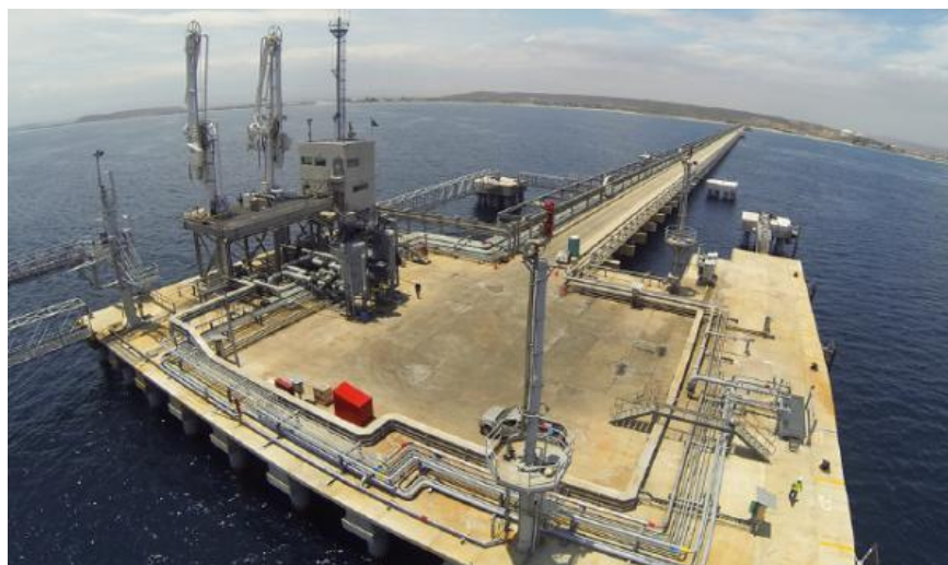
Figura 2.1 Muelle en Estación Monteverde para Recibimiento de Propano y Butano.
