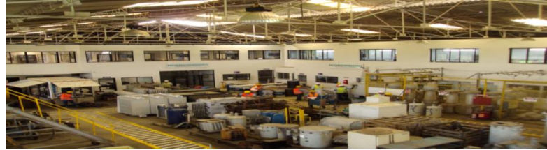
Figura 1 .1: Vista panorámica de la planta de transformadores
