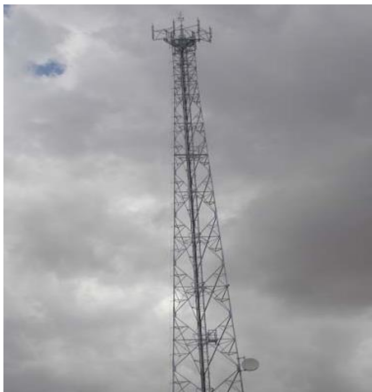
Figura 4.22 Modelo de torre auto soportada. [2]
