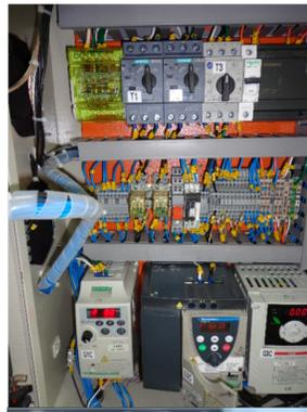
**Figura 4.3:** Panel de fuerza accionamiento de las bombas y centro de carga de 220V.
