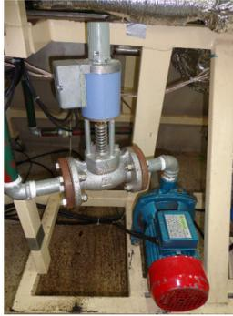
**Figura 4.5:** Bomba y válvula reguladora de flujo a través de la torre de enfriamiento.
