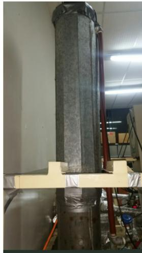
**Figura 4.7:** Torre de enfriamiento, ventilador y tanque de agua a enfriar.
