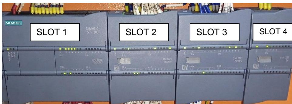
Figura 9. Ubicación de CPU y módulos DI/DQ.
