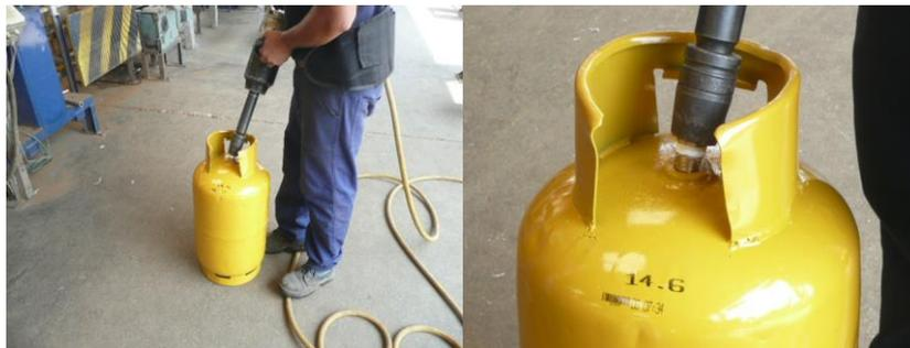
**FIGURA 3.7 OPERACIÓN DE RETIRO DE VÁLVULA CON PISTOLA NEUMÁTICA**
