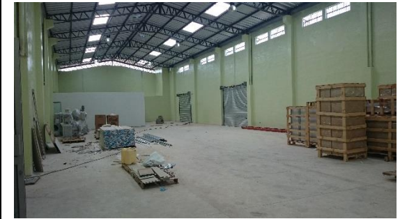
Fotografía 12.- Nuevas instalaciones (bodega de producto terminado)
