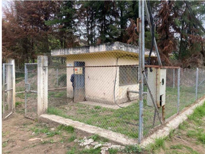
Ilustración 3-1. Caseta de captación
