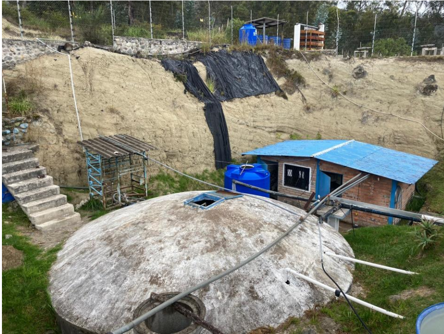
Ilustración 3-4. Tanque de Almacenamiento y Caseta de Cloración
