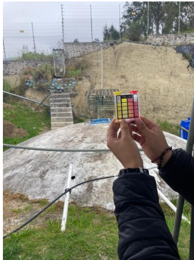
Ilustración 2-4 Lectura de cloro en la planta de tratamiento
