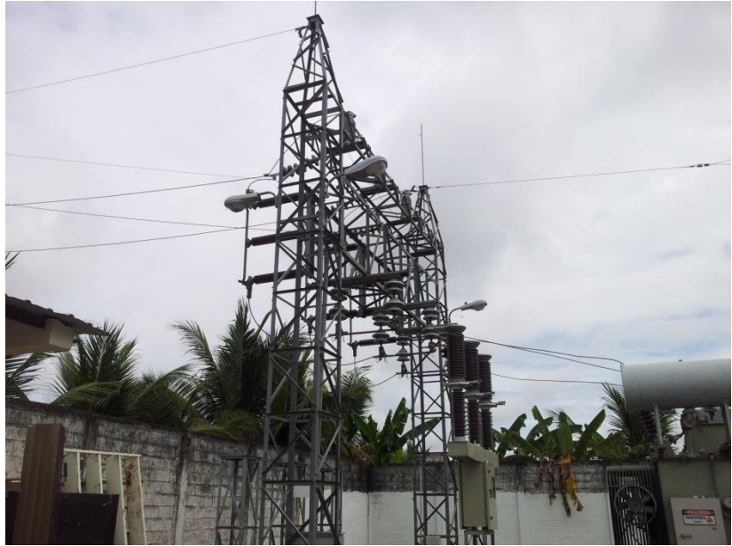
Figura 1.4 Estructura Metálica en el lado de 69KV
