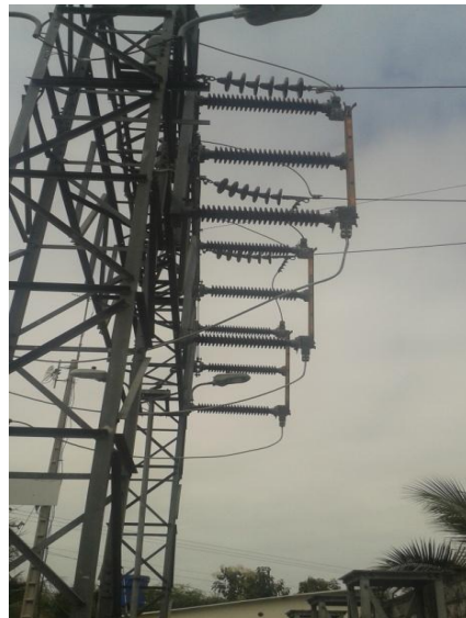
Figura 1.6 Seccionador de Apertura Tripolar
