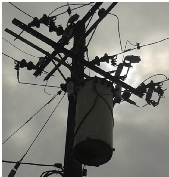
Figura 1.11 Transformador Auxiliar
