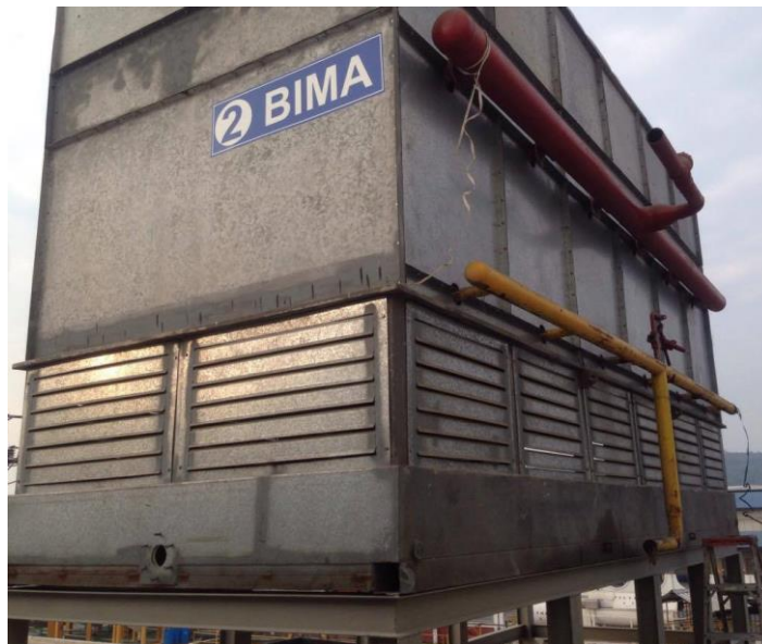
Figura 2.6 Condensador
