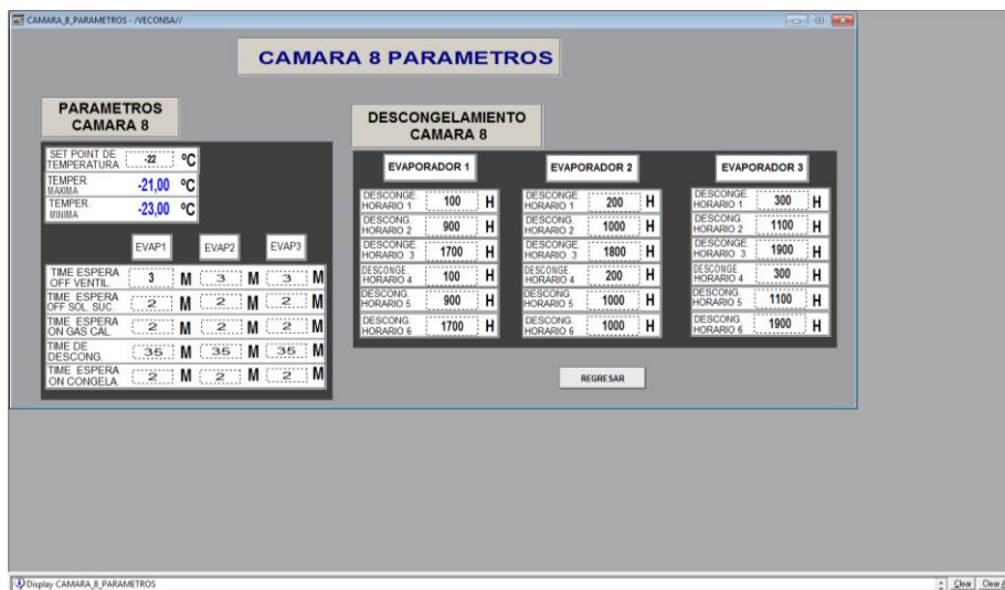
Figura 3.15 HMI de los parámetros de la cámara 8
