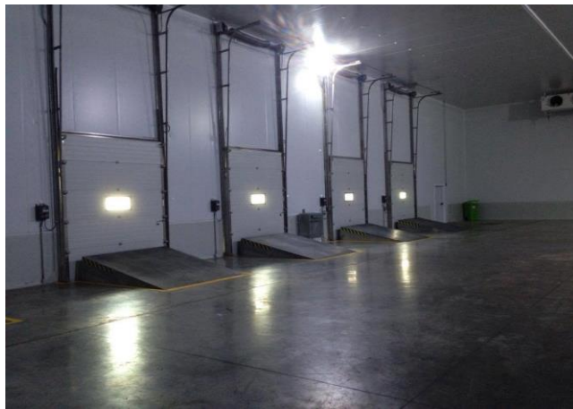
Figura 2.2 Muelles de despacho
