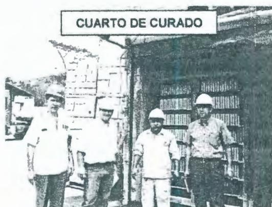
El proceso de curado tiene como finalidad acelerar el endurecimiento del producto para poder ponerlo en el mercado para la venta. El proceso básicamente esta constituido por tres etapas combinadas de aplicación de vapor y reposo, las cuales son "preset", curado y reposo.
