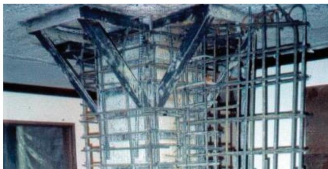
**Figura 2.7 Enchapados y angulares de metal.**
