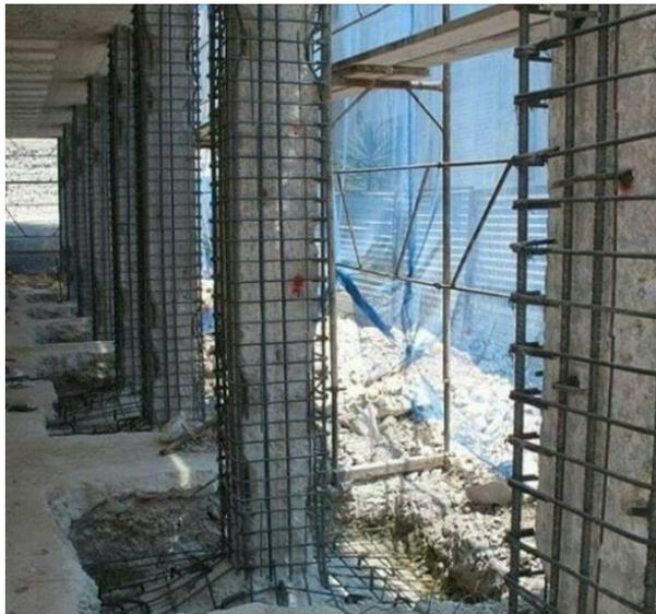
**Figura 2.8 Encamisado de hormigón armado en columnas**
