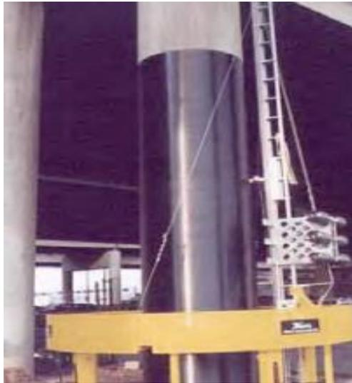
**Figura 2.9 Reforzamiento estructural en columna circular con FRP.**
