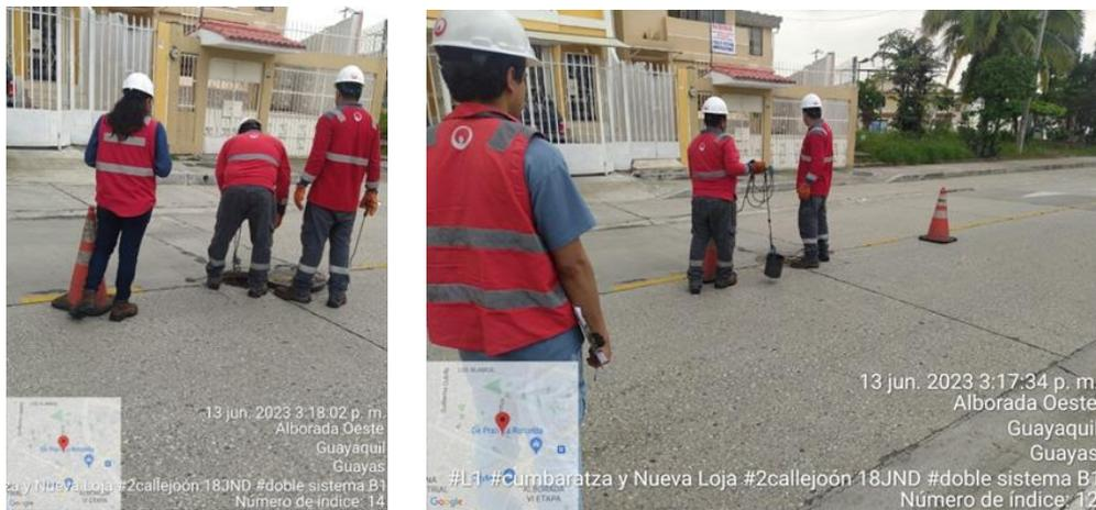
Figura 2.4 Medición de Conductividad en las cámaras AASS
