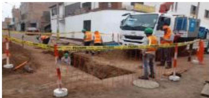
Figura 3.2 Excavación de nicho de entrada
