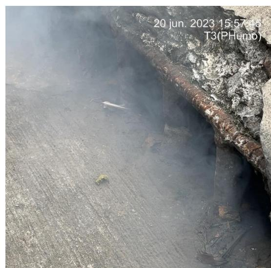
**Evidencia de conexiones erradas encontradas en las salidas de campo**
