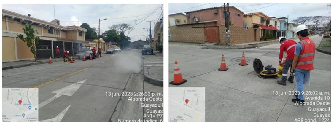
Figura 2.8 Testeo de prueba de humo en cámaras de AASS
