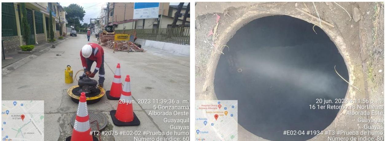
Figura 2.13 Después de la aplicación de la prueba de humo en las cámaras AASS
