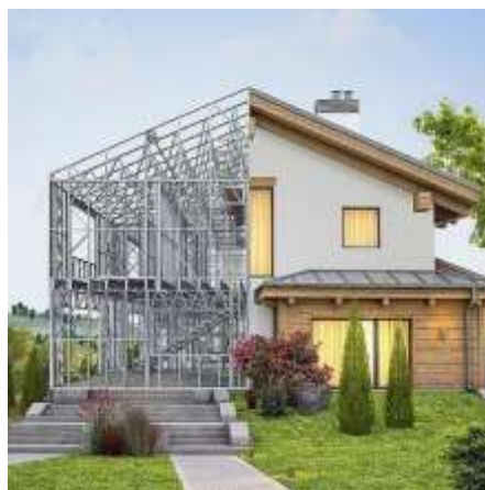
Figura 2.1 Proyecto diseñado con sistema Steel Framing [ChileCubica, 2014]
