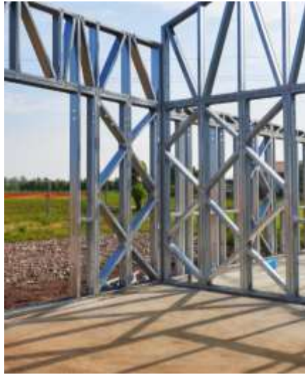
Figura 2.4 Arriostramiento diagonal en K [GreenTech, 2022]
