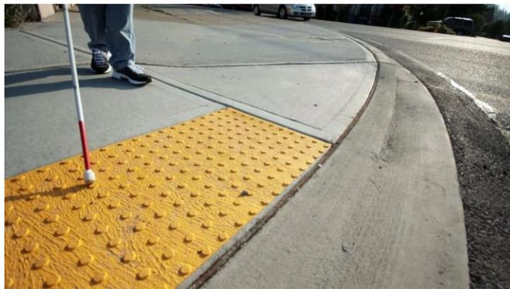
**Figura 3.10 Adoquín podotáctil de botones**
