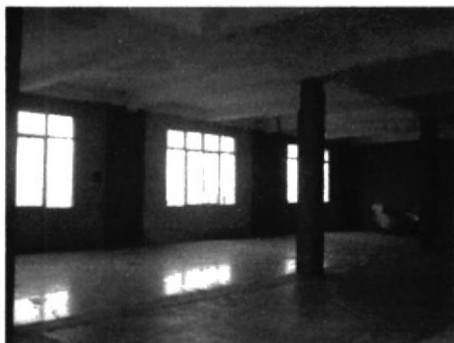
Fig.22 Imagen actual del holl de la segunda planta, donde se ubicarán nuevas aulas
