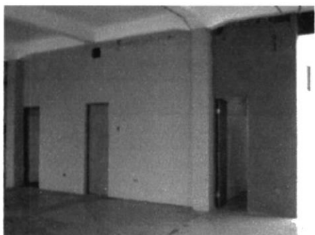
Fig.26 Imagen actual del pasillo de la segunda planta, sección baños.
