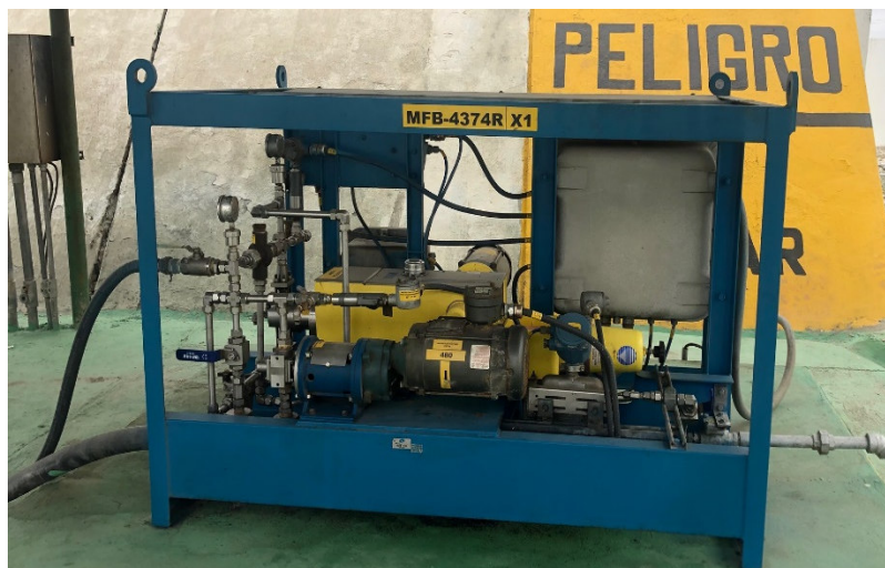
Figura 1.3. Equipos para la inyección del químico. Vista posterior.
