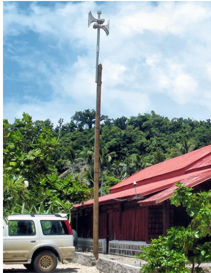
Figura 5.36: Estación de alerta sonora instalada en Francia [44].
