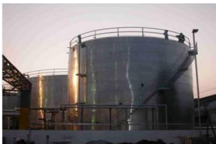
Fuente: Terminal de asfalto del municipio de Guayaquil Elaborado por: Pedro Cedeño, Luis Fernando Rodríguez,
