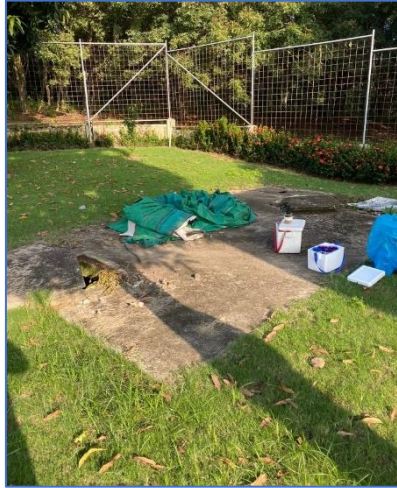
Figura 2.11 Pozo Séptico B [Elaboración propia, 2023].
