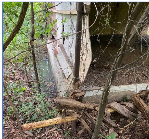
Figura 2.22 Estado actual del pozo séptico E [Elaboración propia, 2023].
