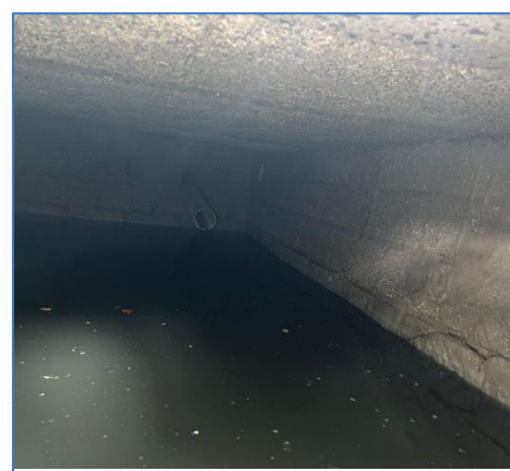
Figura 2.17 Tubería de ingreso al pozo séptico E [Elaboración propia, 2023].
