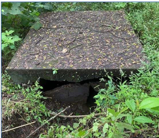
Figura 2.20 Pozo séptico A [Elaboración propia, 2023].
