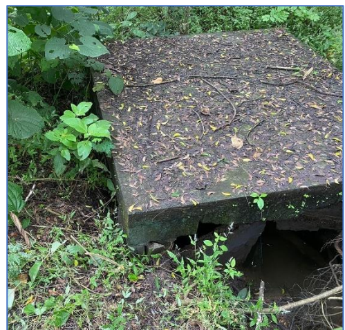
Figura 2.19 Pozo séptico A [Elaboración propia, 2023].
