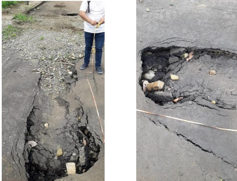
**Ilustración 16. Hundimientos graves. Fuente: Elaboración propia**
