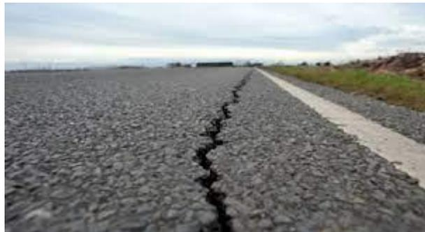
**Ilustración 6. Grietas de borde. Fuente: Miranda, 2010**
