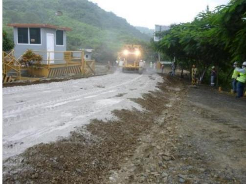
**Ilustración 19. Uso de bases granulares estabilizadas con cemento**
