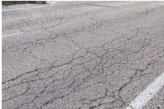
**Ilustración 5. Fisuras por fatigamiento. Fuente: Miranda, 2010**
