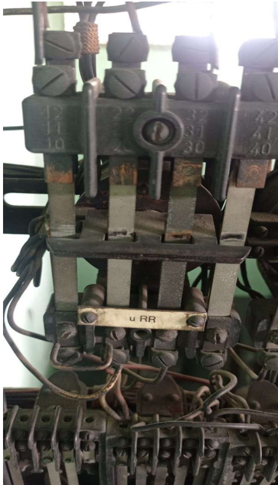
Imagen 1.- Relé utilizado en ascensores
