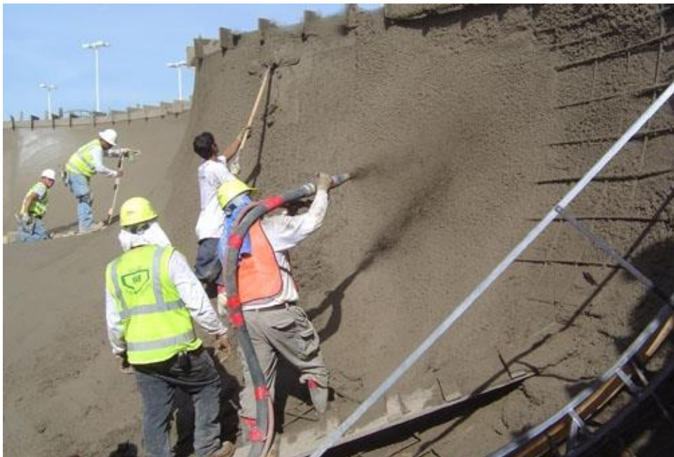
Ilustración 4.2. Proyección de hormigón en paredes (Ochoa, 2014)
