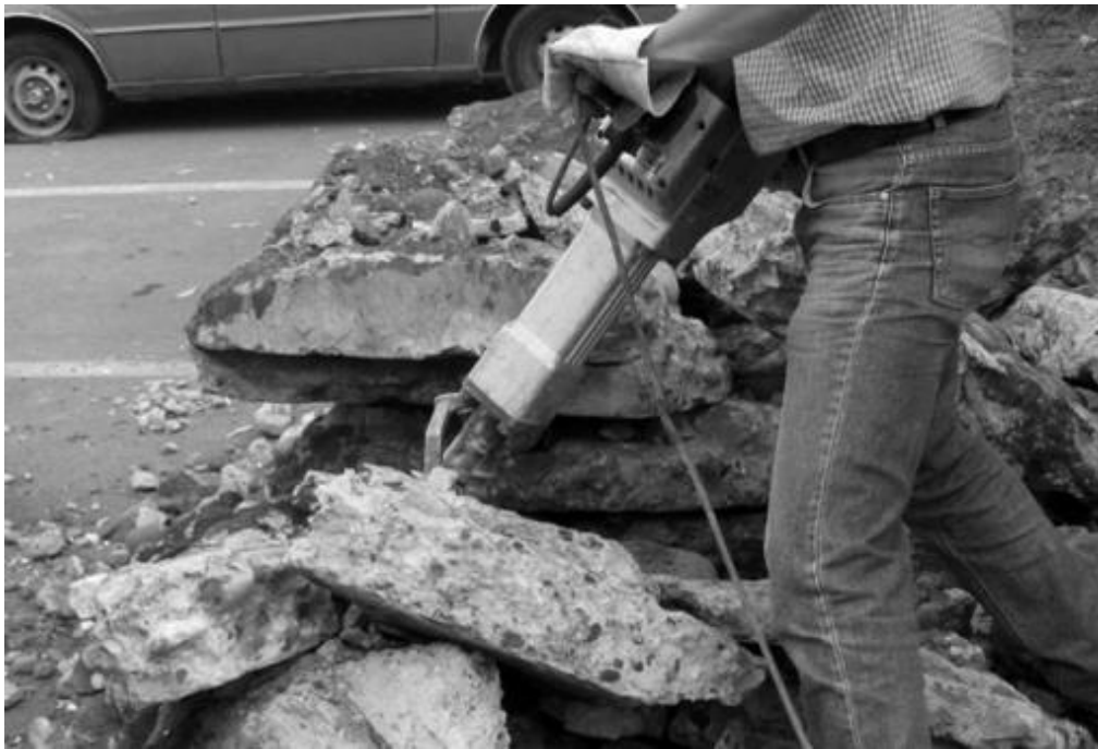
Ilustración 4.3. Demolición de pavimento rígido (Valdés, 2011)
