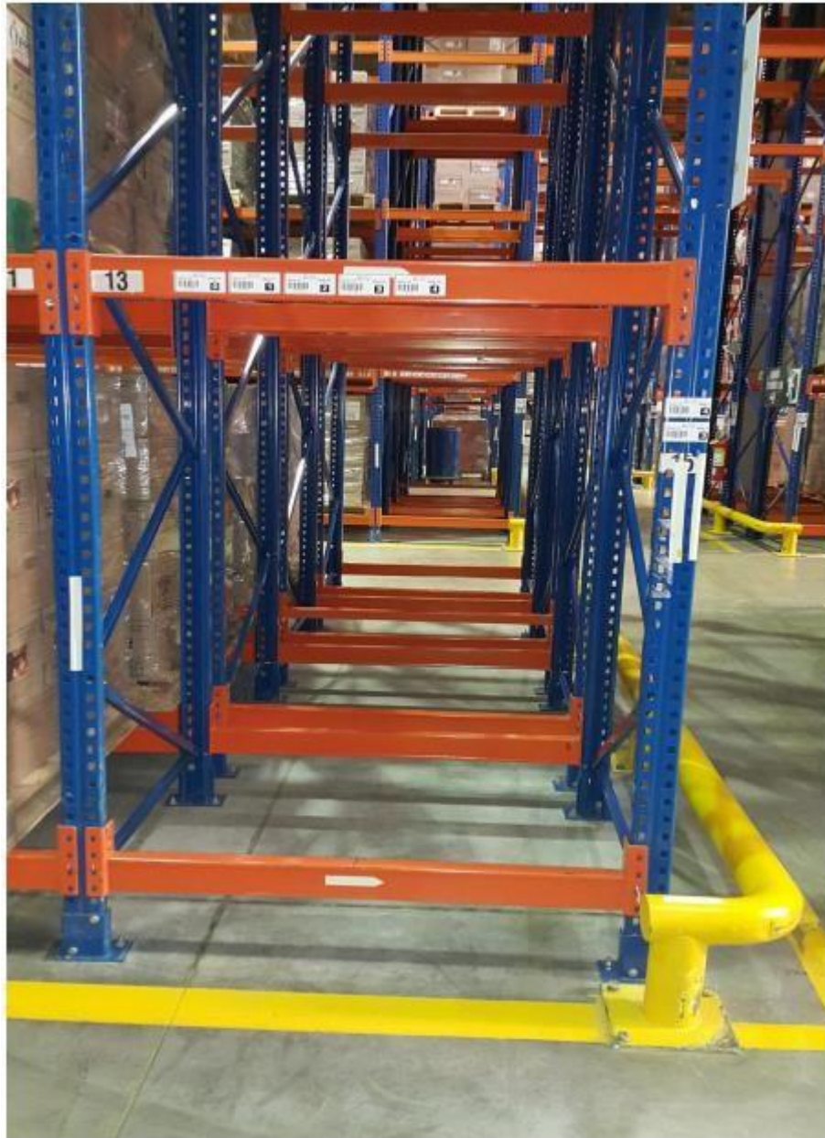
Figura 2.6 Estructura de racks
