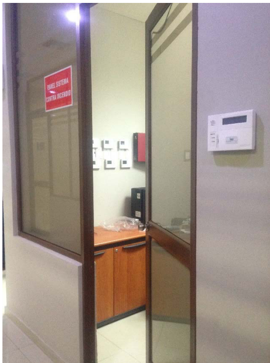
Figura 3.1 Vista exterior del centro de cómputo del GAD Samborondón
