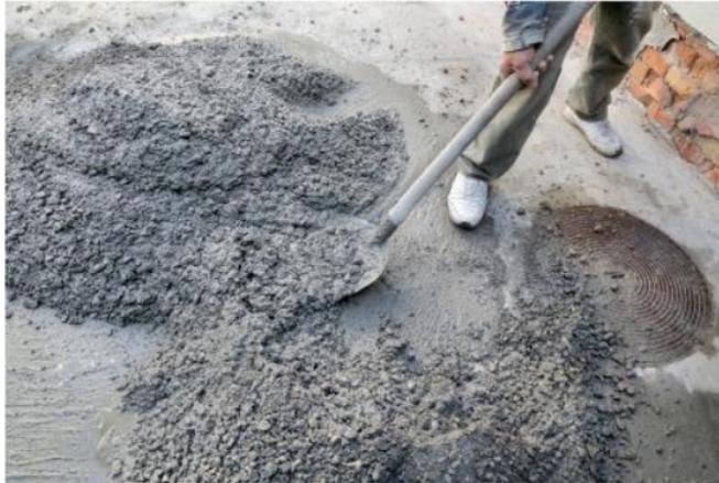
**Figura 4.19 Mezclado de concreto manual**
