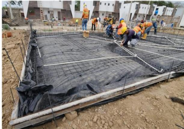
**Figura 4.16 Cimentación de las casas prefabricadas en la urbanización Oporto**
