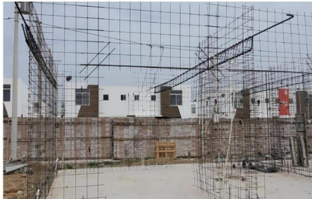
**Figura 4.17 Armadura para muro portantes**
