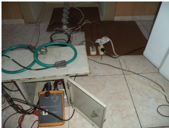
Figura 1.11: Montaje del Banco de Pruebas para TEST 2 con PQ Logger FLUKE
