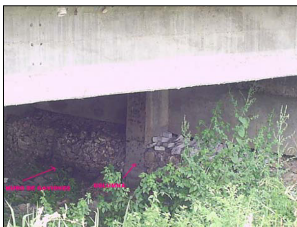
Figura 3.3.1 Detalle estabilidad de estribos Puente El Cerezo
