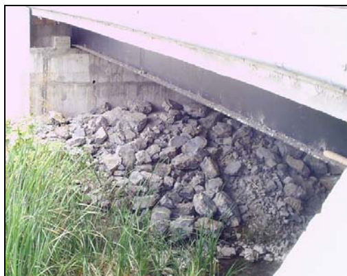
Figura 2.8.20 Vista Parcial Sección Nueva, Puente Bayance
