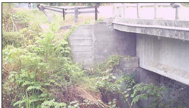
Figura 3.3.4 Vista Parcial Estribo Puente Cajas
