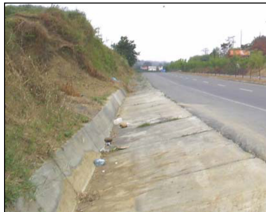
Figura 3.4.1 Vista parcial de cuneta, Vía Guayaquil – Progreso,
