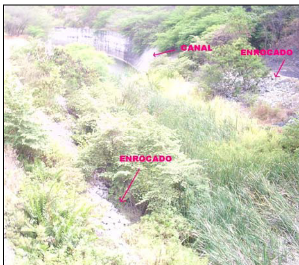
Figura 2.8.6 Vista del canal de Descarga de la Presa Chongón
