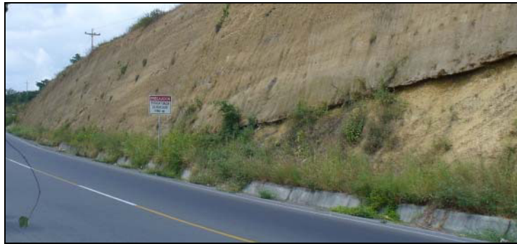
Figura 3.4.3 Vista parcial Talud No. 6,
