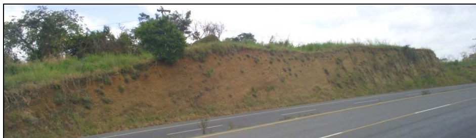
Figura 2.3.4 Vista general del Talud No. 4
