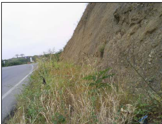
Figura 2.3.7 Vista parcial pie del Talud No. 7
