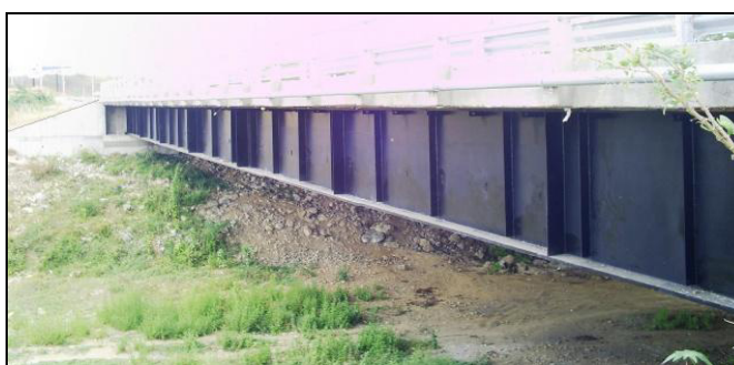
Figura 2.8.31 Vista Lateral Sección Nueva, Puente La Camarona
