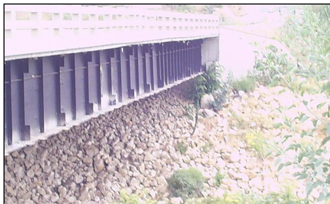
Figura 3.3.10 Vista general enrocado, Puente Río Grande
