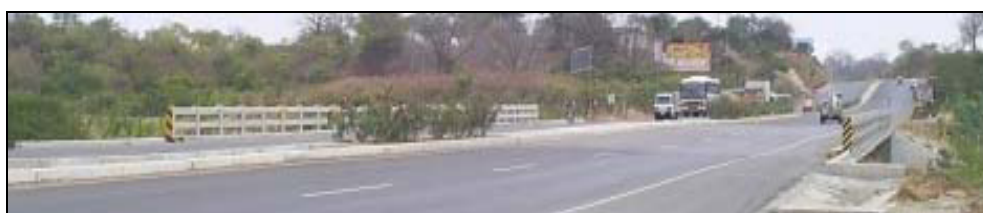
Figura 2.8.27 Vista General Puente Río Grande
