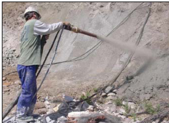
Figura 4.2.2 Aplicación de Hormigón Proyectado, Aplicación Seca
