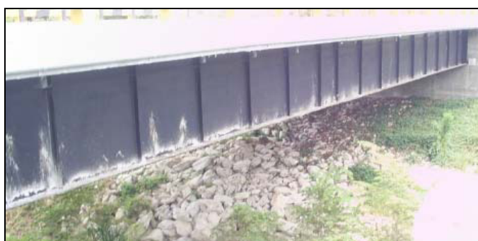
Figura 2.8.24 Vista Parcial Sección Nueva, Puente Daular
