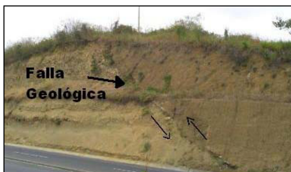
Figura 2.3.5 Vista parcial Talud No. 5
