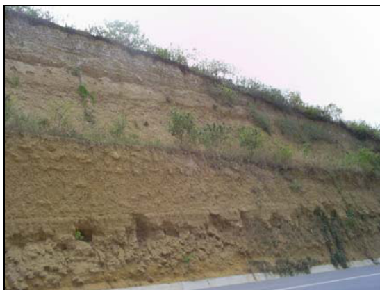
Figura 2.3.9 Vista parcial del Talud No. 8 (Derecho)
