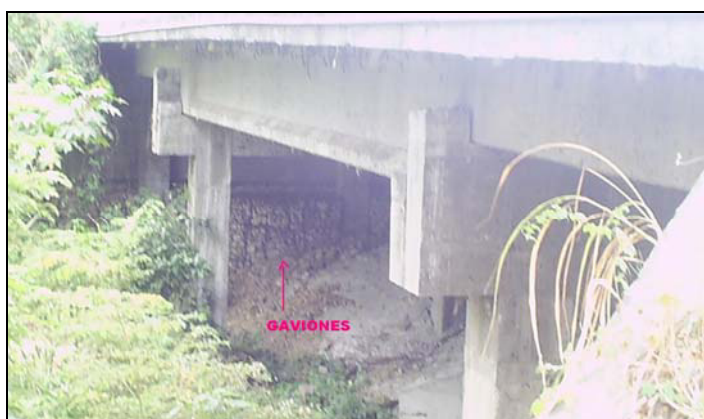
Figura 2.8.9 Vista Lateral Sección Antigua, Puente Sin Nombre
