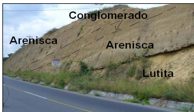
Figura 2.3.6 Vista parcial Talud No. 6
