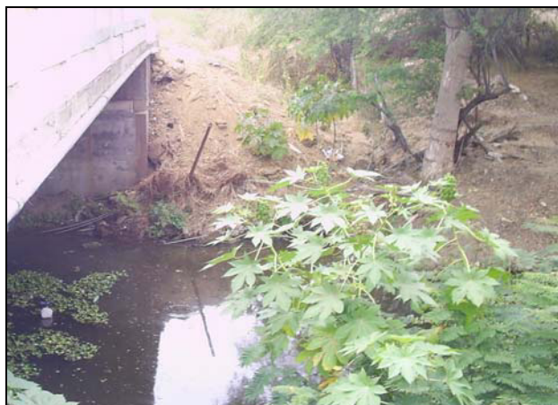
Figura 3.3.5 Vista parcial márgenes Sección Nueva, Puente Río Cajas
