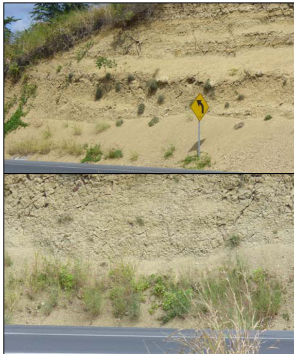
Figura 3.4.2 Vista Parcial y Detalle Pie de Talud No. 5,
