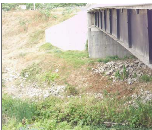
Figura 3.3.2 Vista general estribos Sección Nueva, Puente Descarga Chongón
