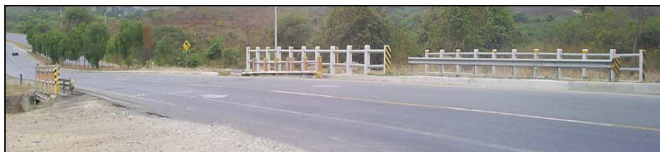
Figura 2.8.15 Vista General Puente Canal Chongón
