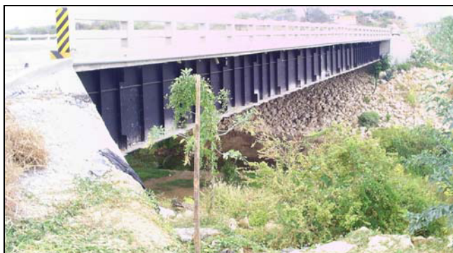
Figura 2.8.28 Vista Lateral Puente Río Grande
