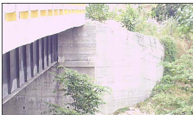
Figura 3.3.9 Vista general Estribos y márgenes, Sección Nueva,
