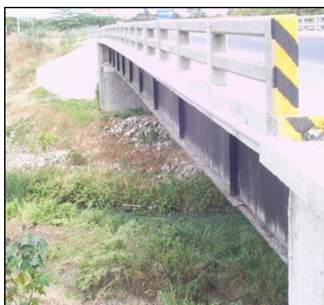
Figura 2.8.7 Vista gral. Sección nueva, Puente Descarga Presa
