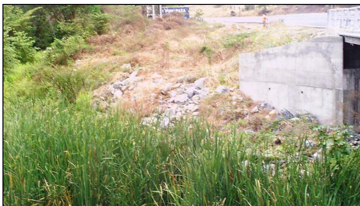
Figura 3.3.8 Vista general Estribos y Márgenes del Puente Bayance
