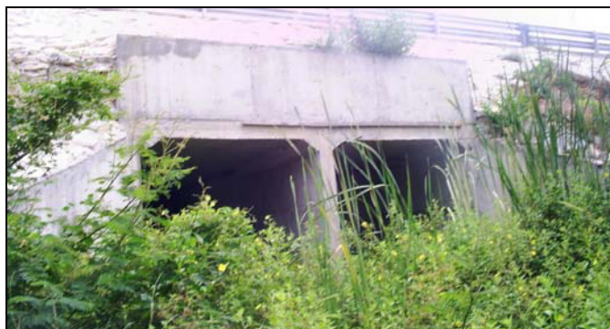
Figura 2.8.10 Vista General Sección Nueva, Puente Sin Nombre
