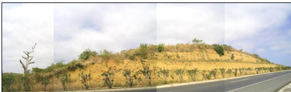
Figura 2.3.8 Vista general Talud No. 8 (Izquierdo)
