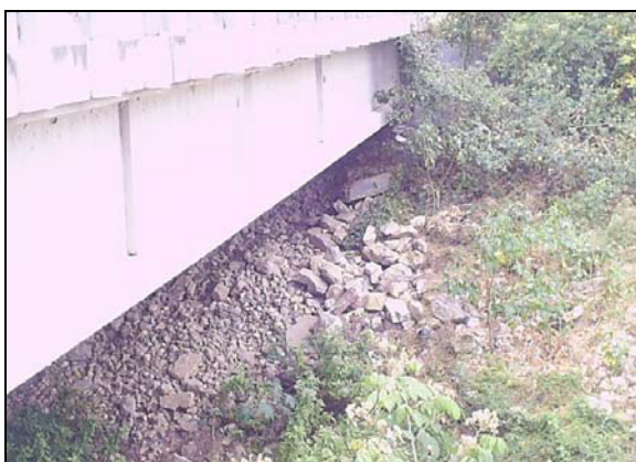
Figura 3.3.11 Detalle parte baja Puente Camarona
