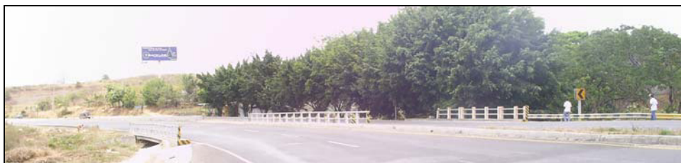
Figura 2.8.18 Vista General Puente Bayance
