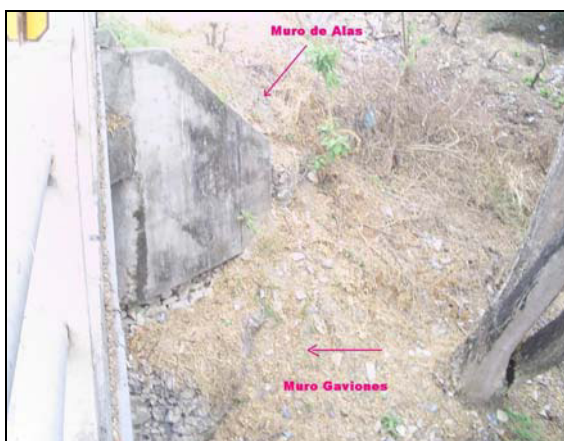
Figura 3.3.3 Vista Parcial estribo Puente Sin Nombre
