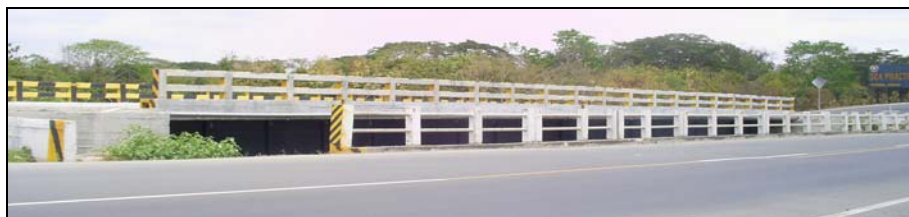
Figura 2.8.22 Vista General Puente Daular
