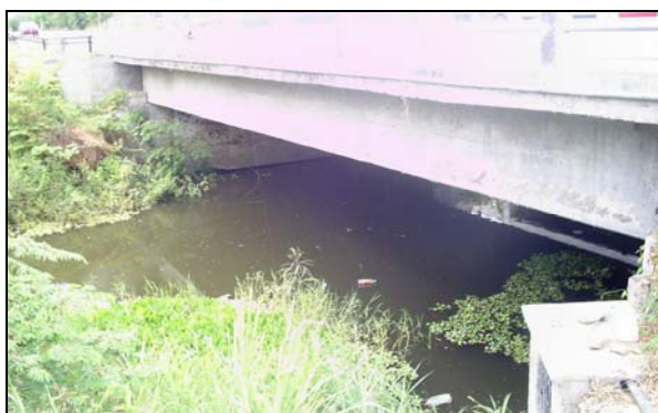
Figura 2.8.13 Vista lateral Sección antigua, Puente Cajas
