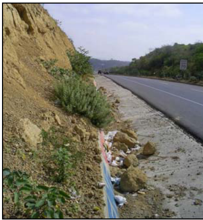
Figura 3.4.5 Vista parcial base del Talud No. 9,
