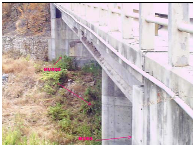
Figura 2.8.5 Detalle muros del Puente sobre Canal de Descarga de la Presa Chongón
