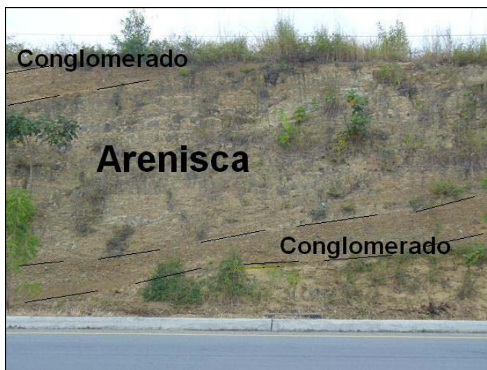
Figura 2.3.3 Vista parcial de la litología del Talud No. 3
