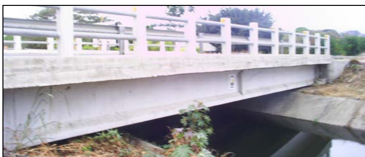
Figura 2.8.17 Vista Lateral Sección Nueva, Puente Canal Chongón
