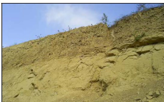
Figura 2.3.10 Detalle del afloramiento de roca en Talud No. 9
