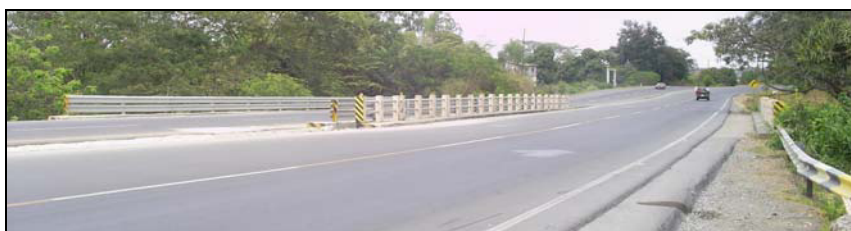
Figura 2.8.8 Vista General Puente Sin Nombre
