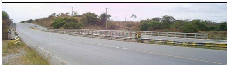
Figura 2.8.4 Vista general Puente Descarga Presa Chongón
