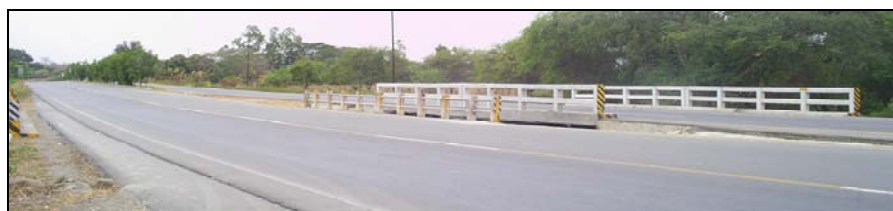
Figura 2.8.12 Vista General Puente Cajas
