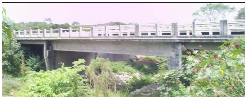
Figura 2.8.23 Vista Lateral Sección Antigua, Puente Daular
