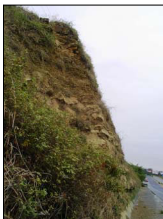
Figura 2.3.2 Vista parcial del Talud No. 2
