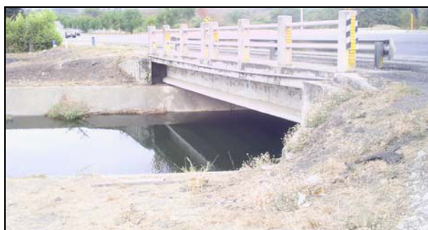
Figura 2.8.16 Vista general Sección Antigua, Puente Canal Chongón
