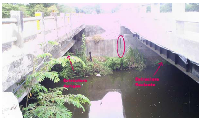
Figura 2.8.14 Vista general de las dos secciones del Puente Cajas
