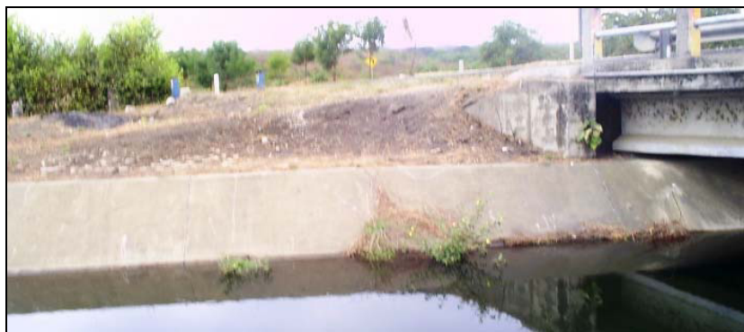
Figura 3.3.6 Vista Parcial Margen y Estribo, Sección Antigua
