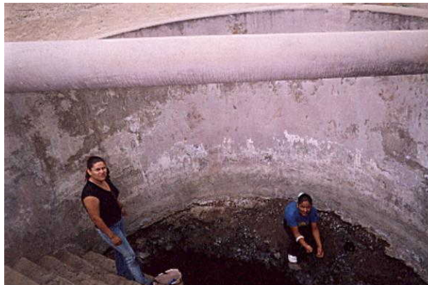
FIGURA 11. UNO DE LOS POZOS DE JOA.
