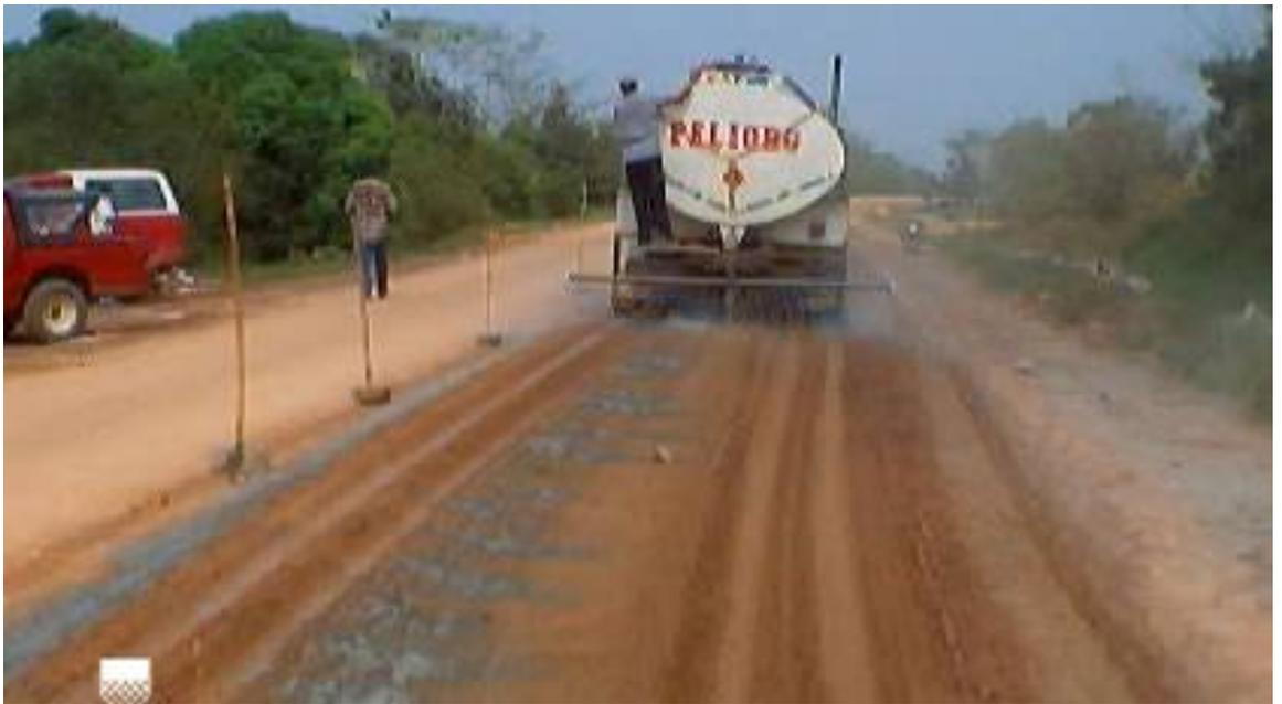
Hidratación con tanquero (humedad optima)
