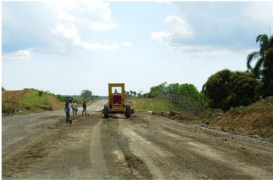
Fig. 4.4 Nivelación de ultima capa de subbase
