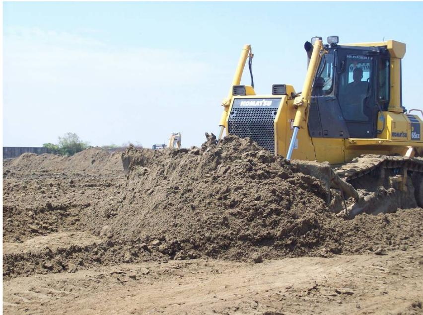
Sección de Relleno con tractor
