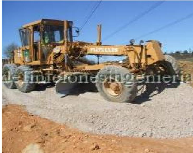
Nivelación del material estoqueado por motoniveladora o descabezado
