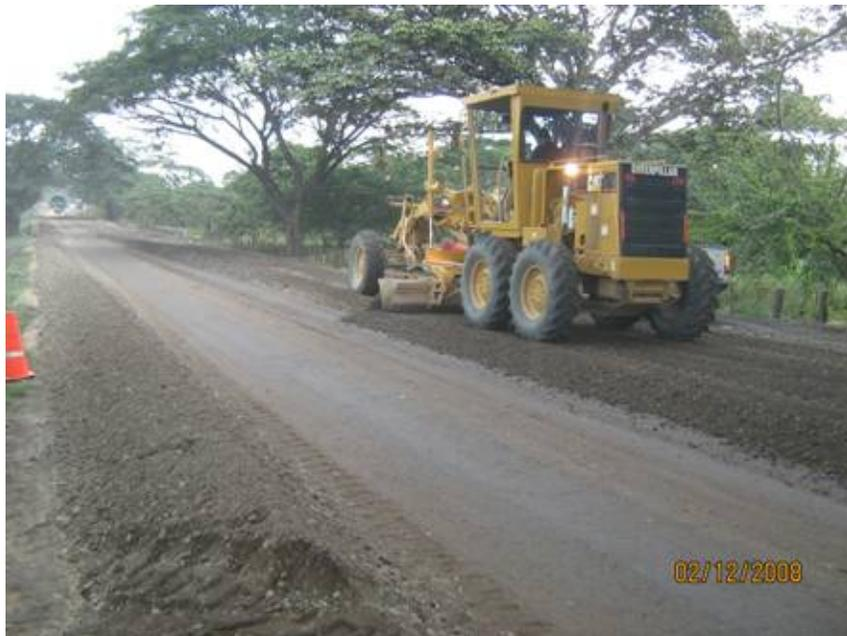
Nivelación del material estoqueado por motoniveladora
