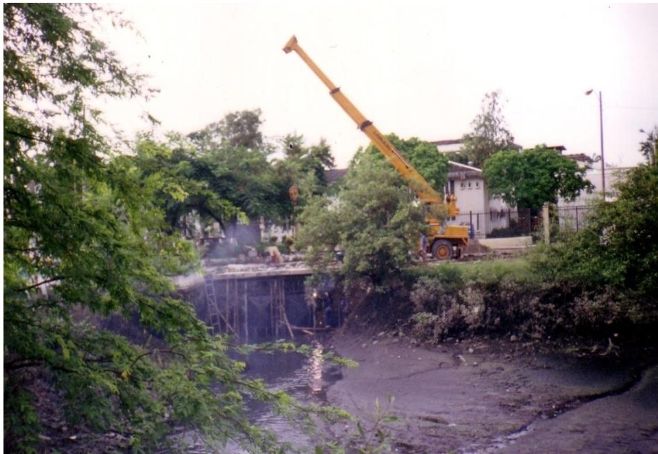
FIGURA 2.18 DESMONTAJE DE LAS COMPUERTAS
