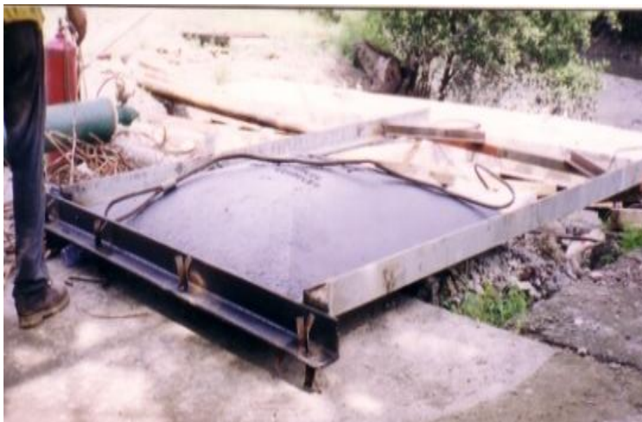
FIGURA 2.20 COMPUERTAS REHABILITADAS OPERACIÓN DE SANBLASTING Y PINTURA EPÓXICA
