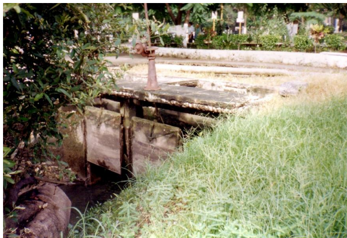
FIGURA 2.12 ESTADO DE ABANDONO DE LA COMPUERTA
