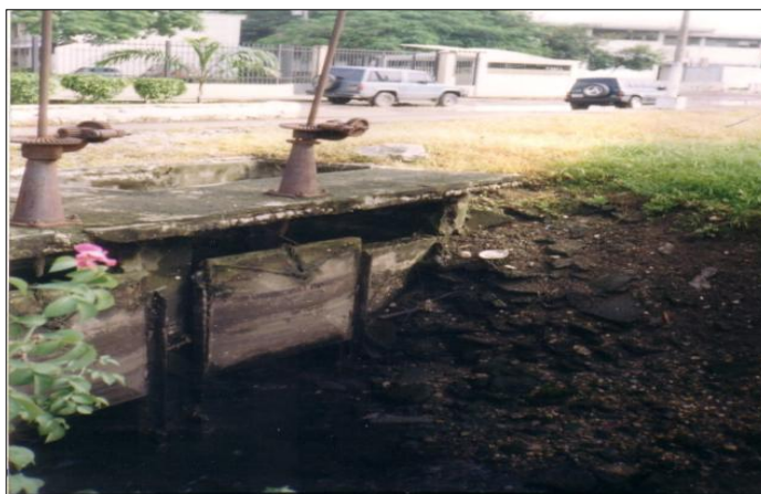
FIGURA 2.12 ESTADO DE ABANDONO DE LA COMPUERTA
