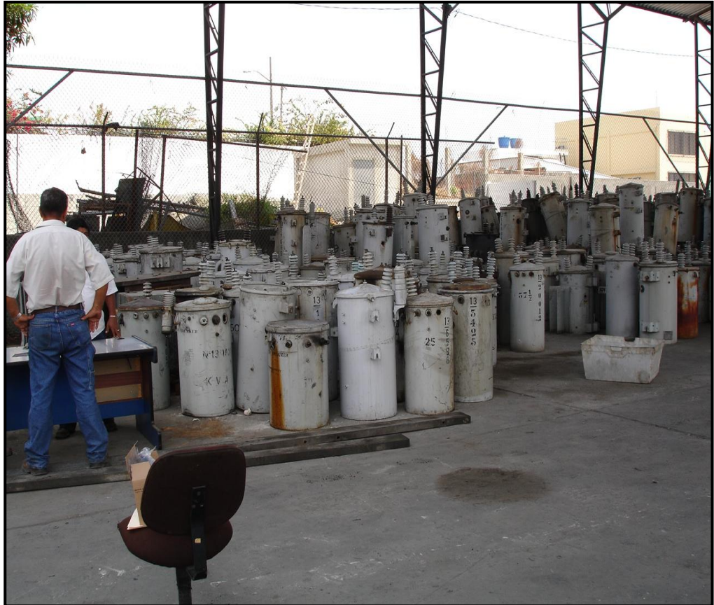
FIGURA 4.1. TIPO DE BODEGA EXISTENTE
