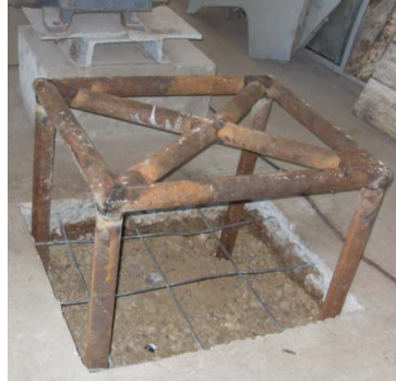
FIGURA 1.24. ARMADURA DE CIMENTACIÓN
