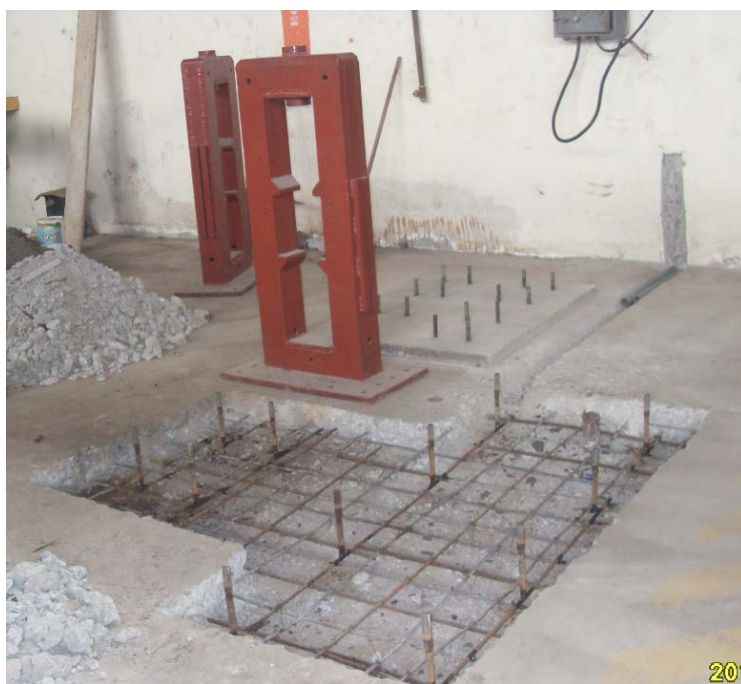
FIGURA 2.33. COLOCACION DE LOS PERNOS DE ANCLAJE
