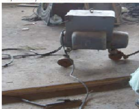
d) Soldadura Eléctrica
