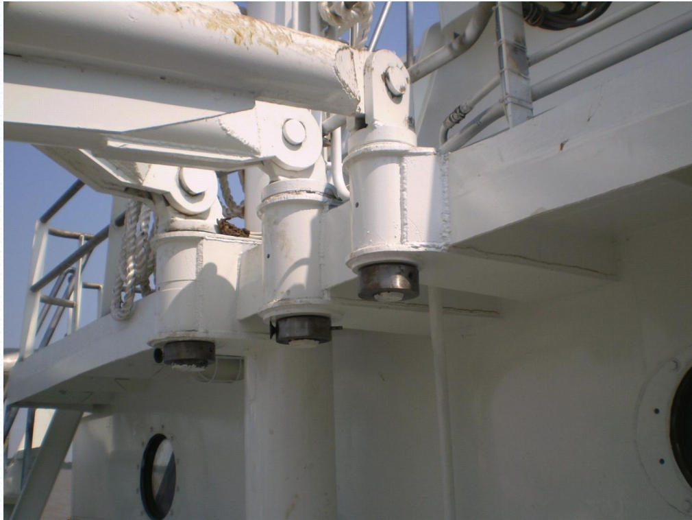
Figura No. 7. Detalle de Pines y bocines de la arboladura
