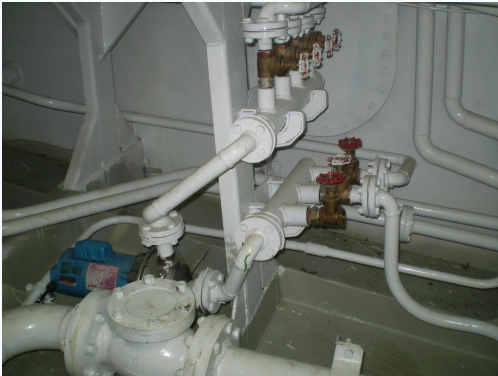
Figura No. 41. Sistema de intercambio de diesel
