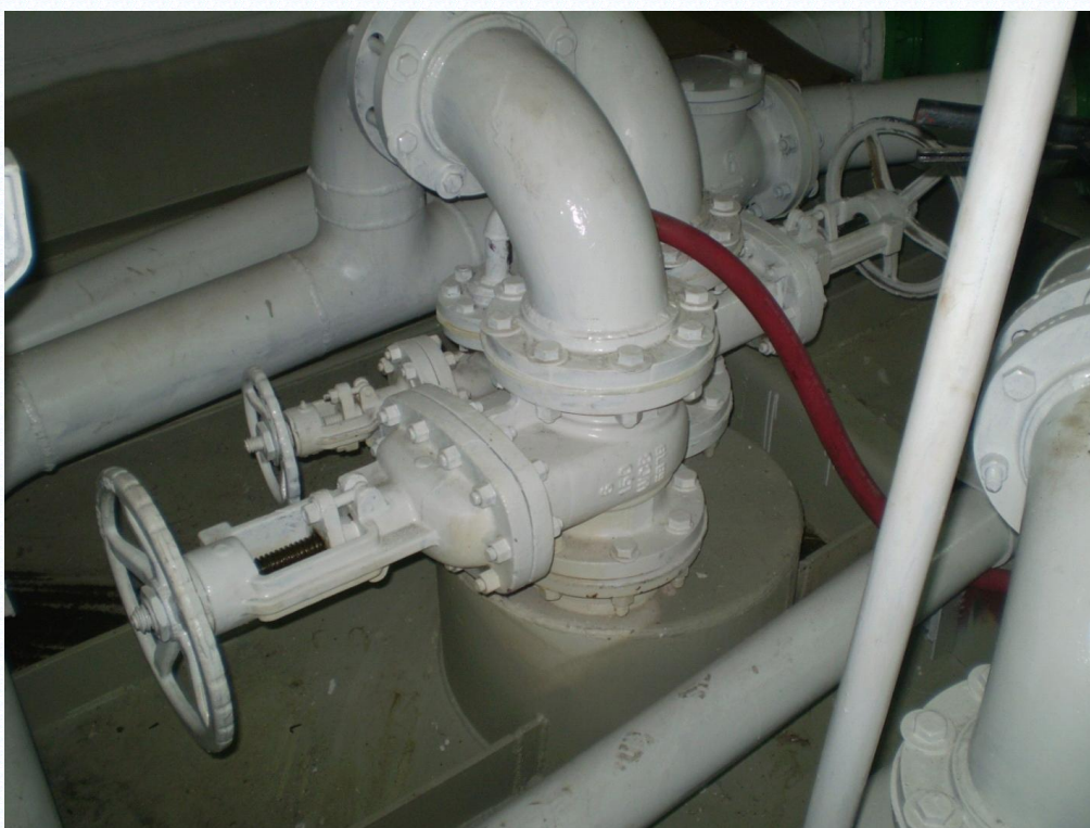
Figura No. 42. Vista de la válvula de fondo
