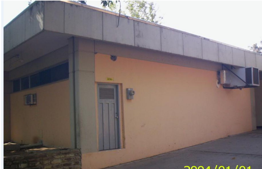
Figura 6. Vista exterior de subestación eléctrica Í C/T 21Î .
