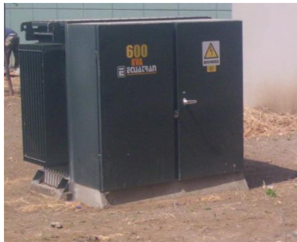
Figura 8. Vista exterior de transformador trifásico tipo Padmounted.
