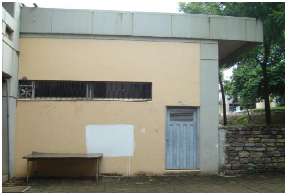
Figura 7. Vista exterior de subestación eléctrica Í C/T 22Í .
