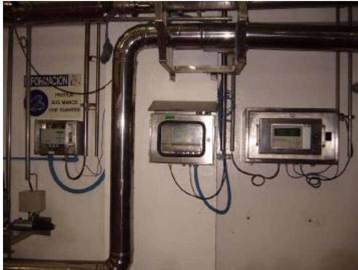
Figura 5.27.- Instrumentación de der a izq. (Analizador de extracto original, oxígeno y turbidez) calibrada y operativa.
