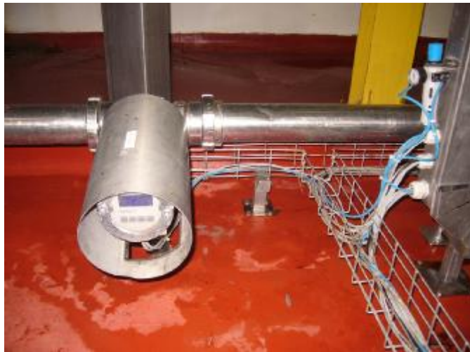
Figura 5.28.- Instrumentación (Analizador de CO2 en línea) calibrado y operativo.
