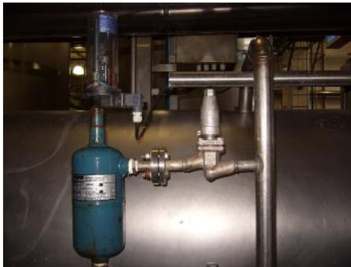
Figura 5.30.- Instrumentación (Boya de nivel de Amoniaco) calibrada y operativa.
