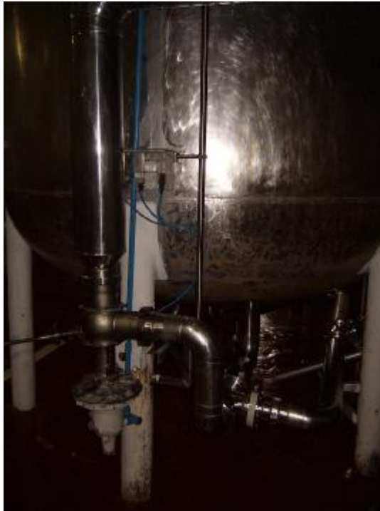
Figura 5.29.- Instrumentación (Válvula de codo y posicionar I/P) calibrado y operativo.
