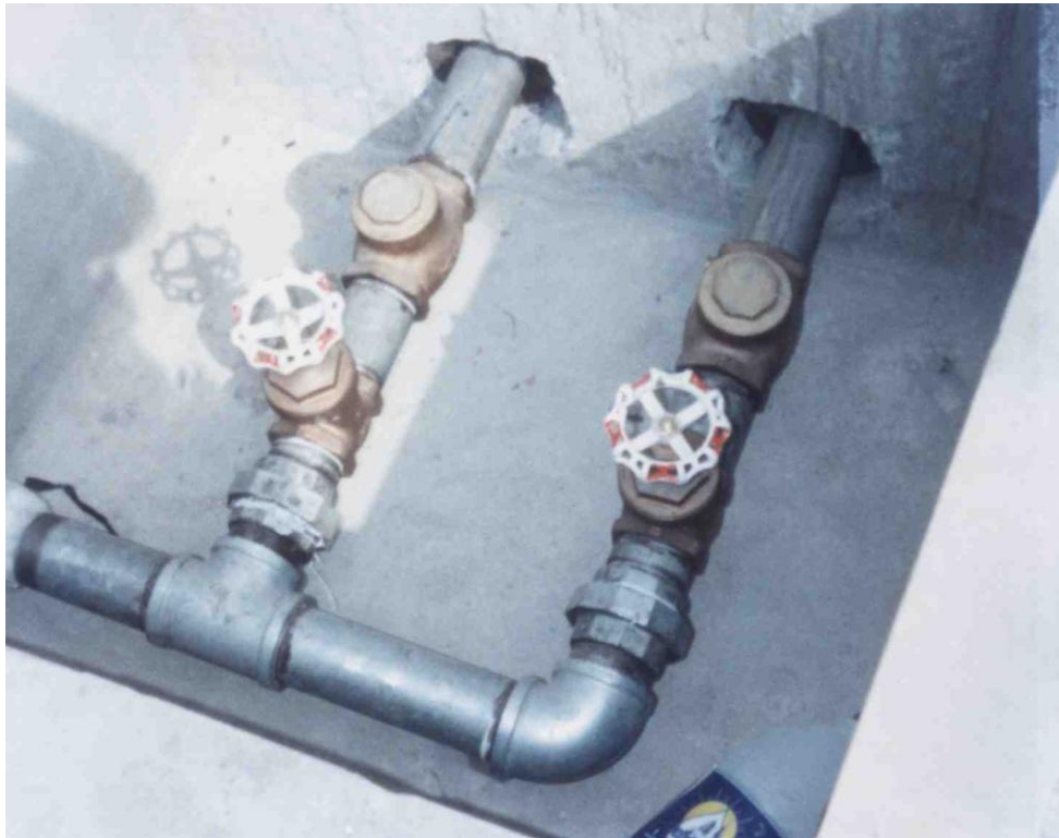
FIGURA 2.3 INSTALACIÓN DE VÁLVULAS DE COMPUERTA Y CHEQUE
