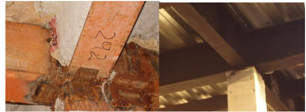
(a) Soldadura de filete en unión viga I – columna (b) vigas apoyadas sobre columna
